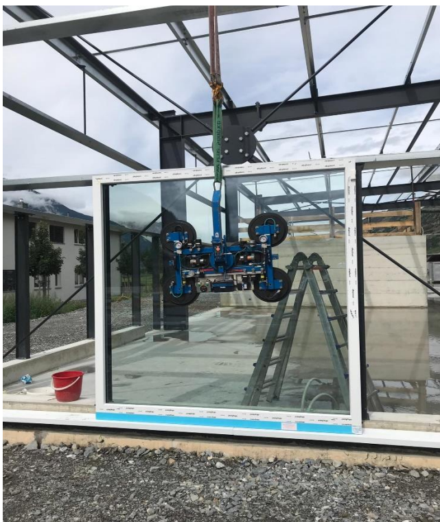
Montage Schaufenster, 3fach verglast
