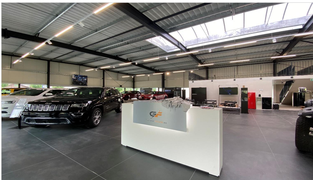
Lichtdurchflutung und Entrauchung mit zentralem Oblicht
