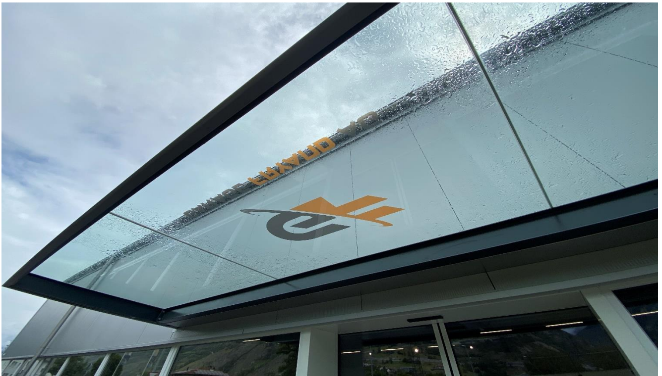
Glasvordach mit integrierter Leucht-Werbung
