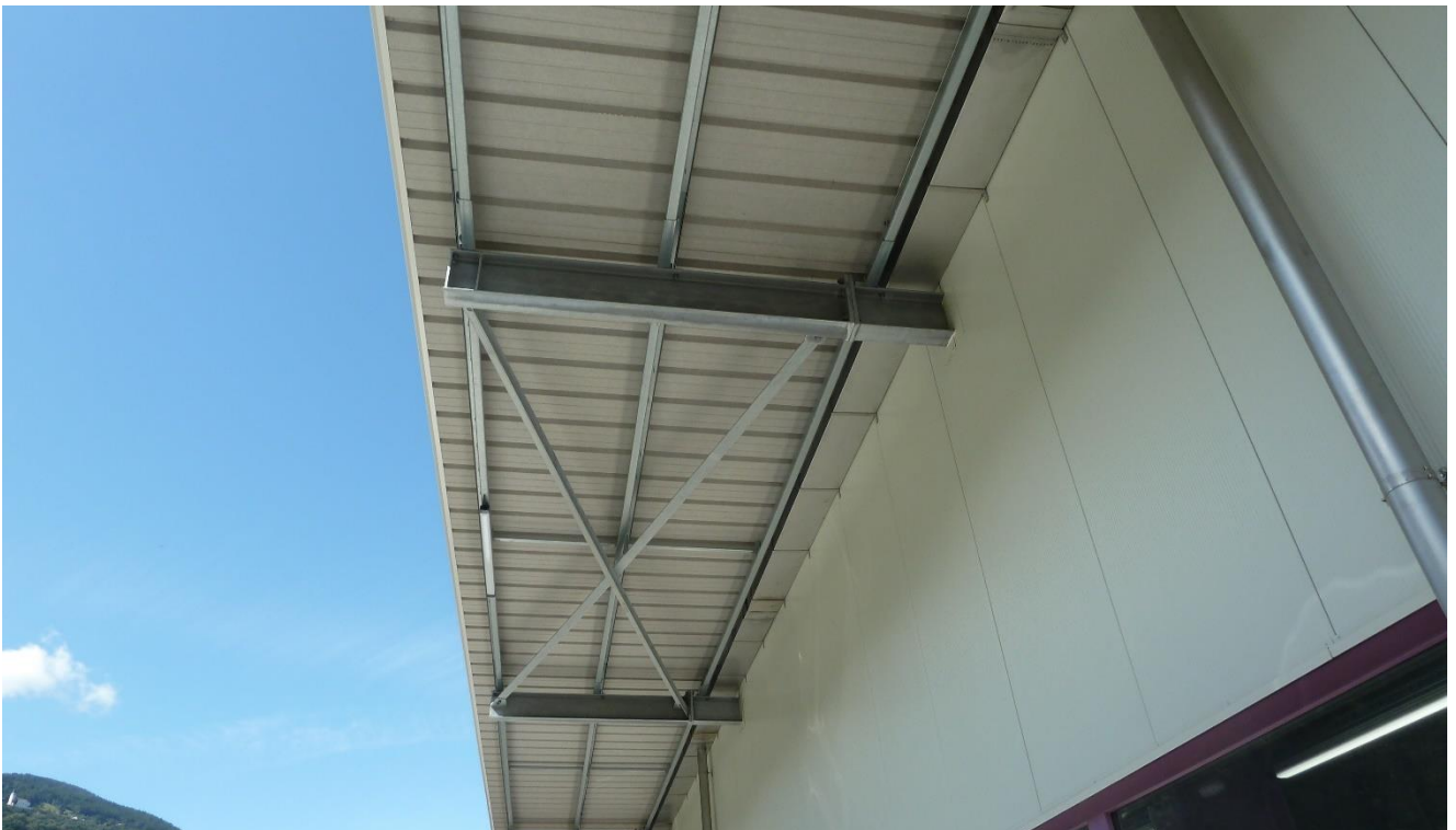
Vordach mit Antikondensvlies
