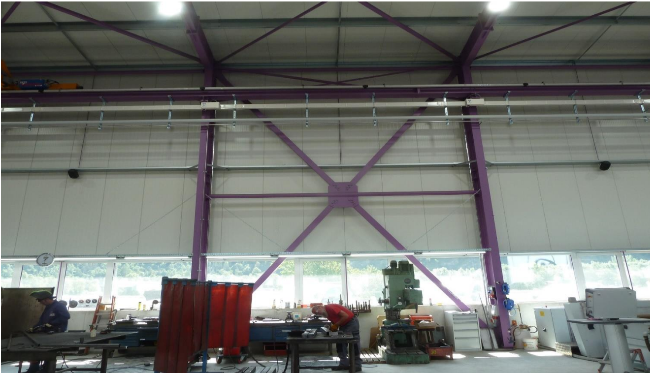
Massive Windverbände in Erdbebenzone
